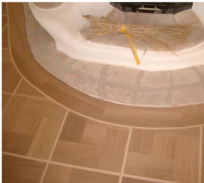
Beim Objekt von Kraft begeisterte sich die Jury vor allem für die Einarbeitung des Randfrieses an den asymmetrischen Kaminofen.
